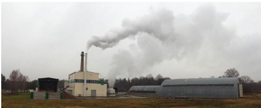
1.6.att. Biomases koģenerācijas stacija Rūjienas ielā 5
