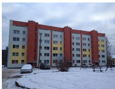
1.23b.att. Renovēta daudzdzīvokļu ēka Valkas pilsētā
