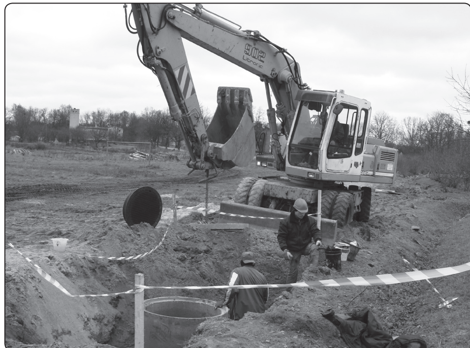
Kārķu ciemā jauna kanalizācijas tīkla izbūve
